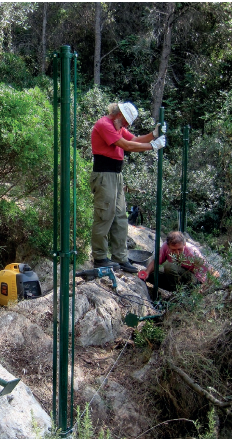
Colocación de vallado perimetral en unas de la cuevas de importancia para quírópteros declaradas ZEC. BRIGADAS NATURA 2000.
