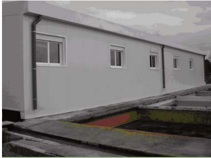
Nuevo edificio de laboratorio y oficinas del CIP El Palmar
