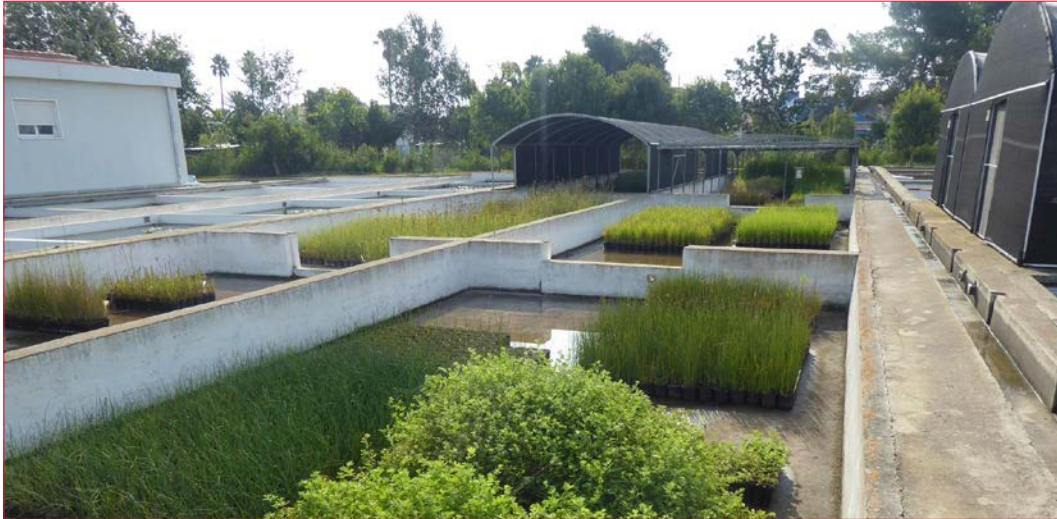
Balsas de helófitos con umbráculos en las instalaciones del CCEDCV.
